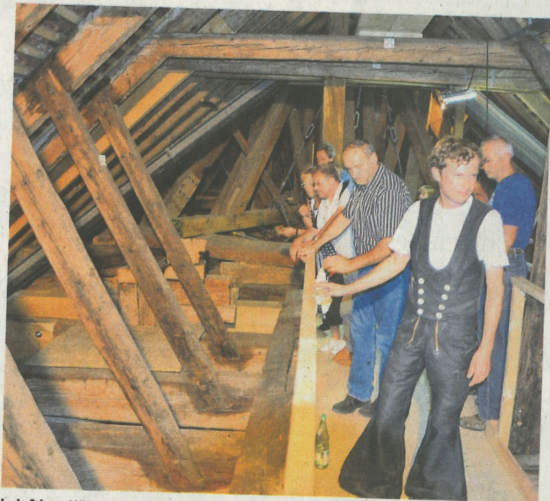
In luftiger Höhe: Zimmermann Martin Büchle (vorne) erläutert die Sanierungsmaßnahmen im historischen Dachstuhl.
