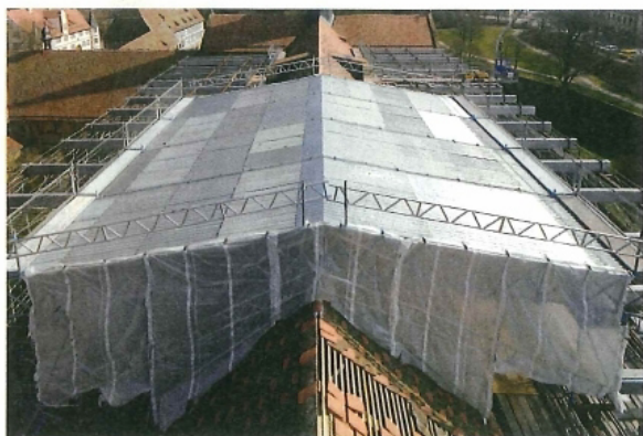
Auf dem Hauptschiff der Kirche war in der Bauzeit ein verschiebbares Wetterschutzdach auf Schienen installiert
