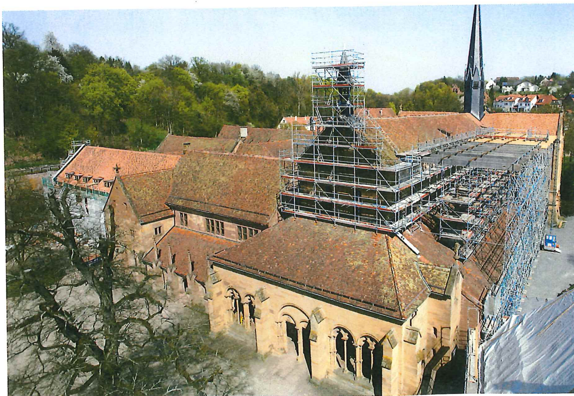
Die Dachlandschaft des Klosters: Über dem Seitenschiff der Kirche ist ein hängendes Gerüst installiert, das rechts auf dem Außengerüst aufliegt Foto: Layher
